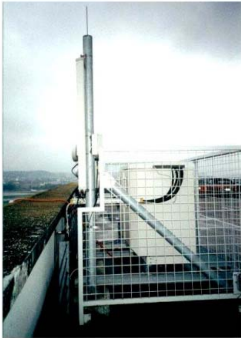
BTS de l'aéroport de Zurich (équipement Nokia)
