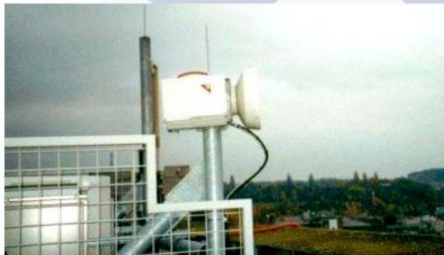
liaison micro onde à l'aéroport de Zurich
