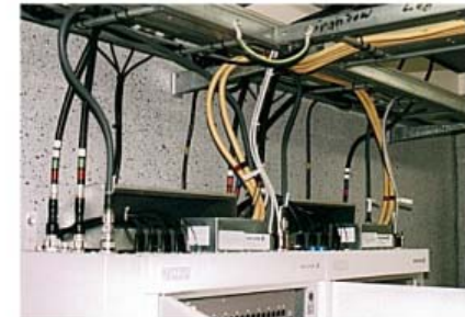
départ des câbles d'antennes
