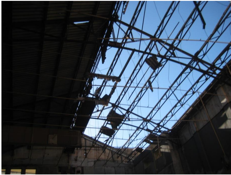
Figure II. 39 : Disparition de la toiture
