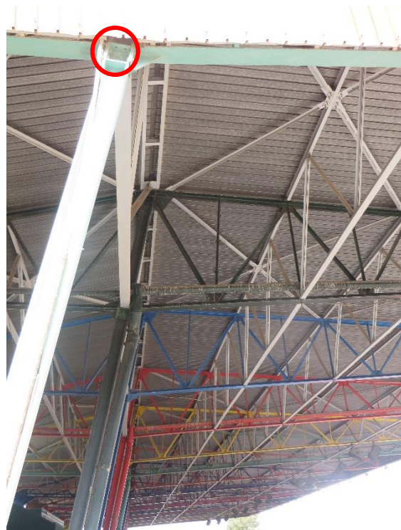
Figure II. 4: Raidisseur au niveau du poteau
