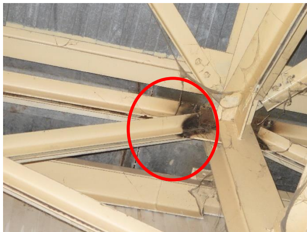
Figure II. 55 : Soudure au niveau du gousset
