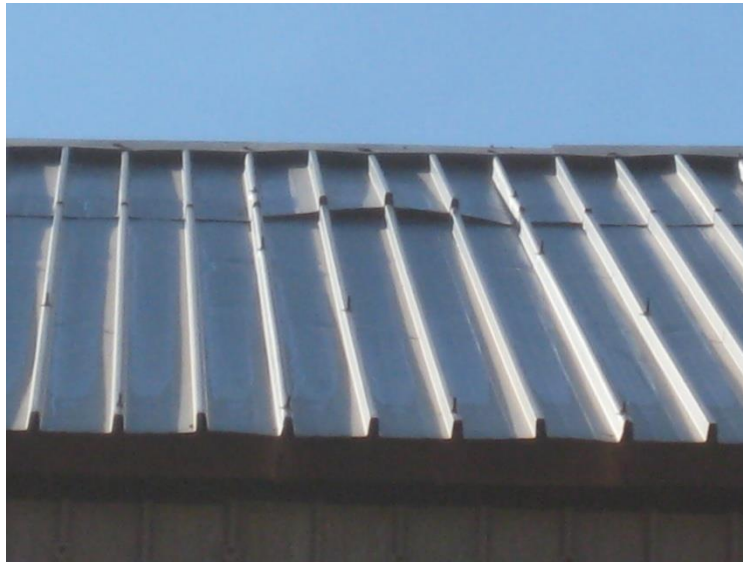
Figure II. 34 : Décollement de bardage de la toiture.
