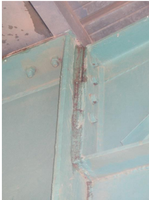
Figure II. 7: Ecoulement d'eau sur l'assemblage
