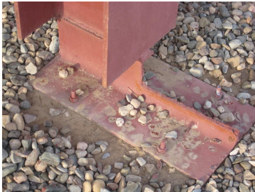
Figure II. 49 : Pied de poteau métallique
