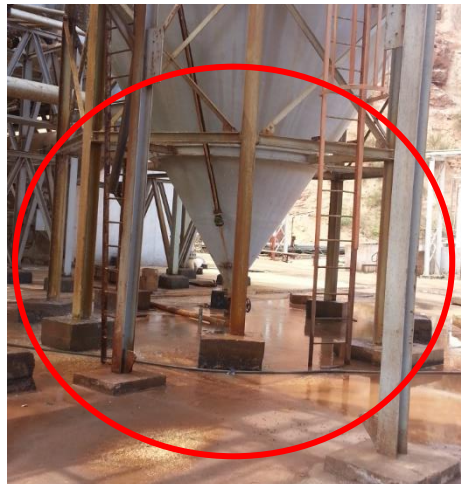
Figure II. 25 : Disparition du contreventement
