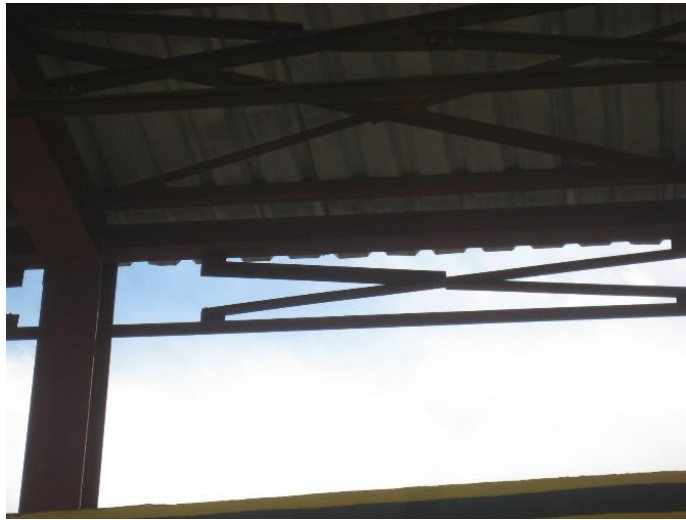
Figure II. 48 : Contreventement métallique
