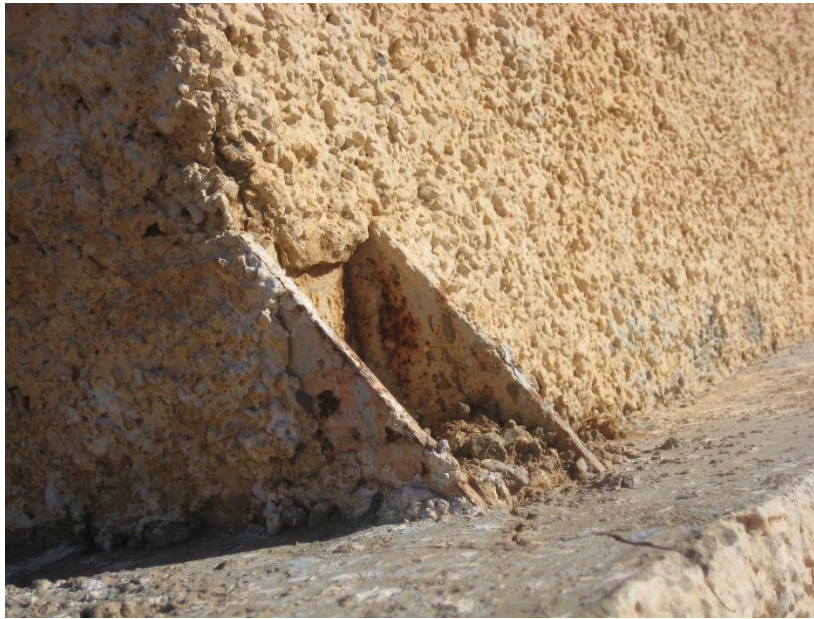
Figure II. 32 : Corrosion du raidisseur de poteau
