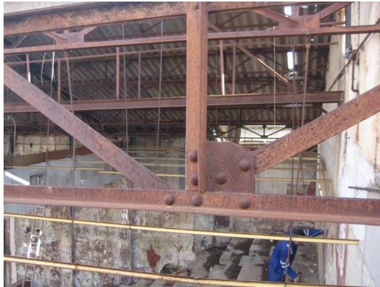
Figure II. 41 : La corrosion de la ferme
