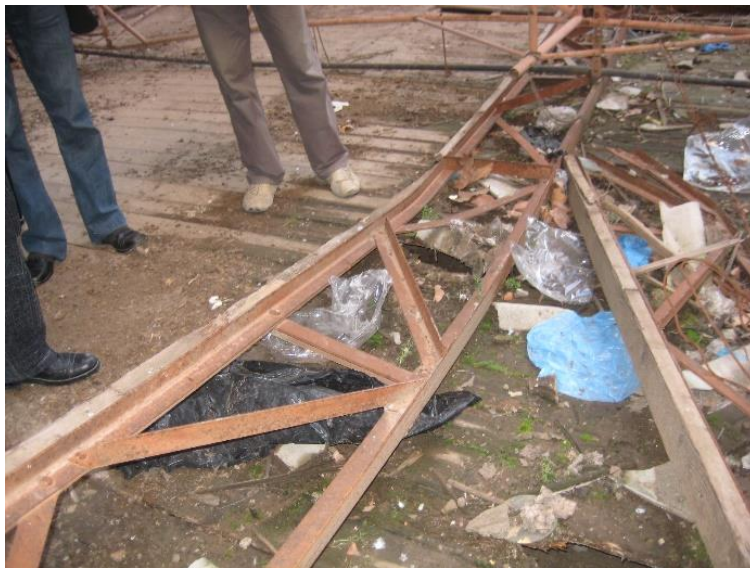
Figure II. 40 : Chute de la panne métallique
