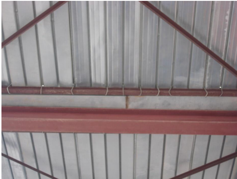
Figure II. 46 : Les crochets de fixations de la toiture
