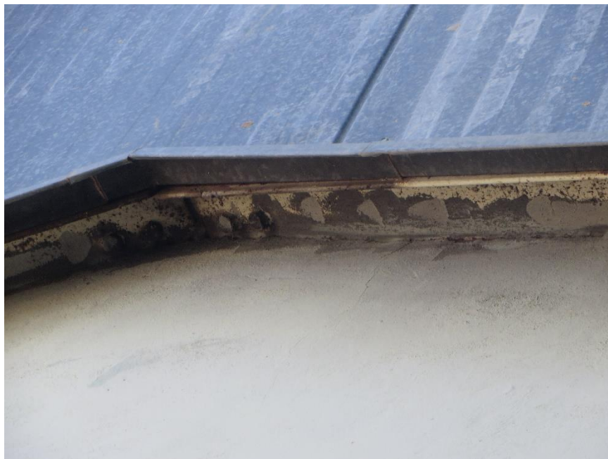
Figure II. 60 : Corrosion de la lisse de bardage.
