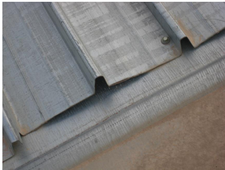
Figure II. 45 : Mauvaise fixation de couverture
