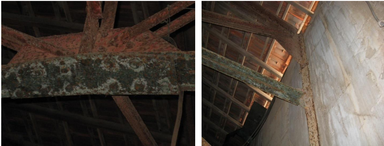
Figure II. 18: Eléments inférieurs de la poutre en corrosion
