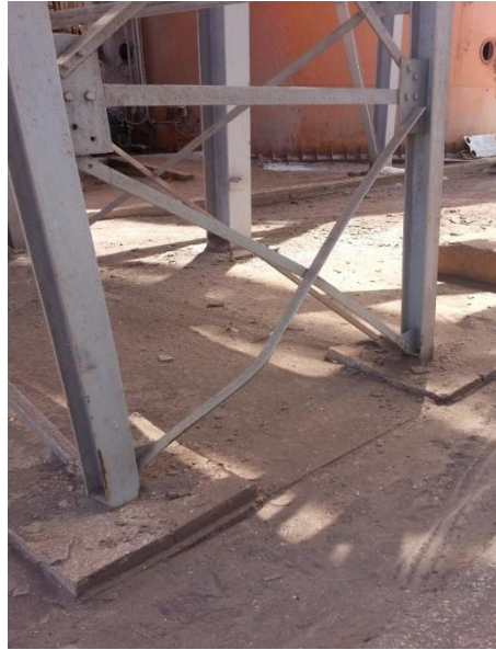
Figure II. 24 : Déformation du contreventement
