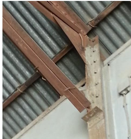
Figure II. 52 : Corrosion des éléments métalliques
