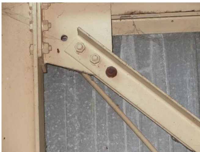
Figure II. 58 : Mauvaise conception de gousset pour contreventement.
