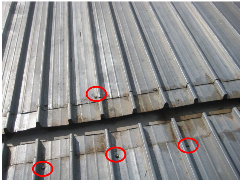
Figure II. 47 : Les vis de fixation de la toiture
