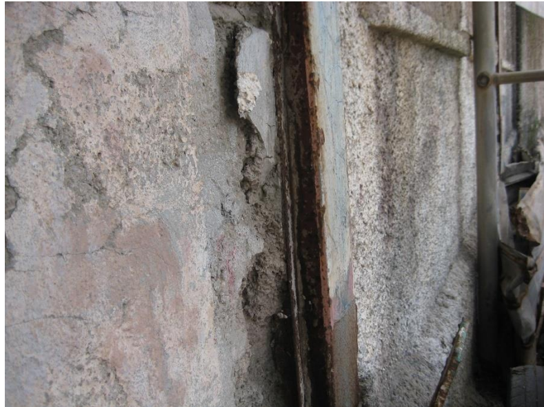
Figure II. 16 : Corrosion de poteaux métallique
