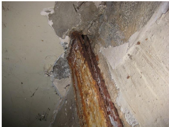
Figure II. 19: Corrosion du poteau d'intérieur.
