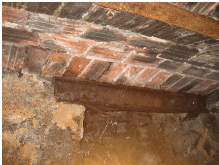
Figure II. 42 : Corrosion de l'acier au sou sol de la salle
