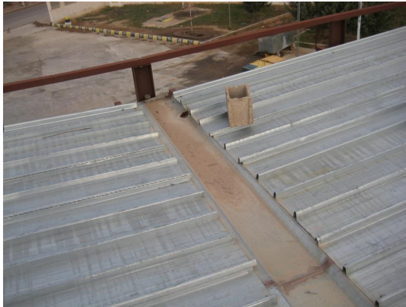
Figure II. 44 : Vue d'un chéneau métallique
