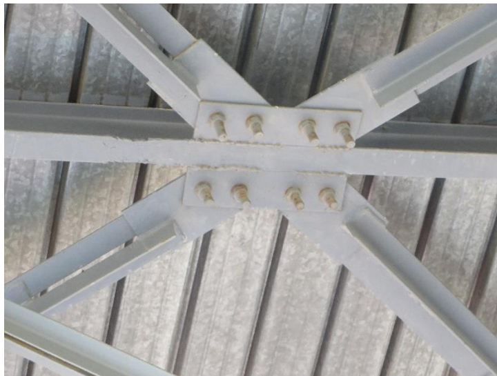
Figure II. 8: Corrosion sur les boulons du contreventement horizontal
