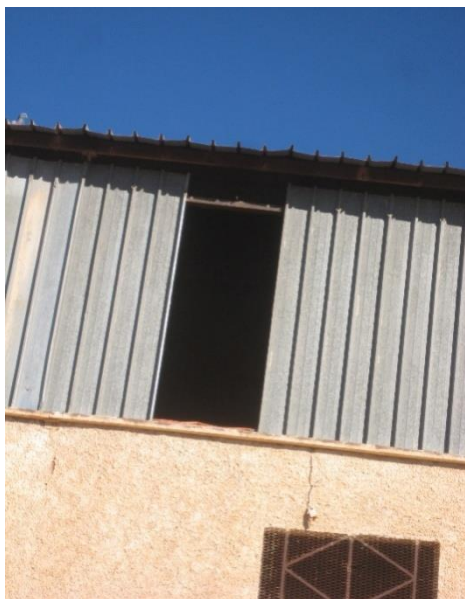
Figure II. 29 : Disparition du bardage latéral
