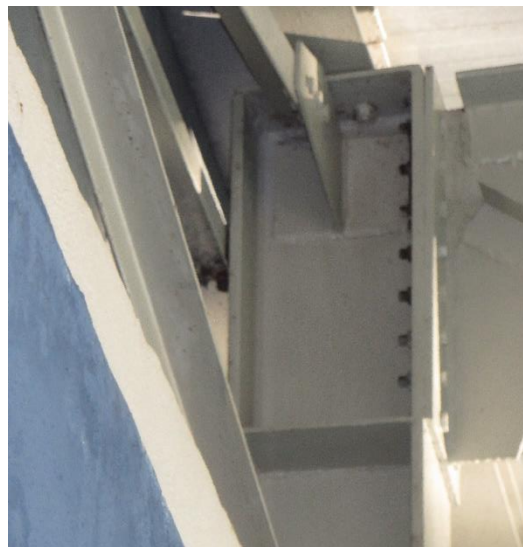
Figure II. 13: Corrosion des boulons d'assemblages
