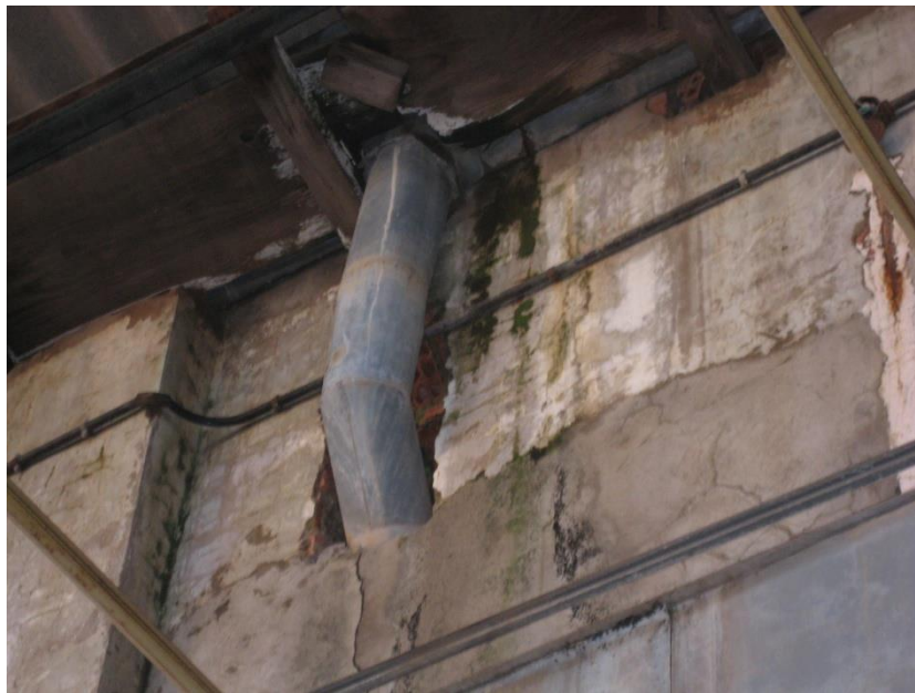
Figure II. 38 : Chéneau métallique et apparition de lichens sur le mur.
