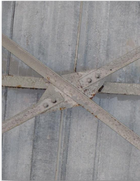
Figure II. 12: Corrosion sur les éléments métallique de la toiture
