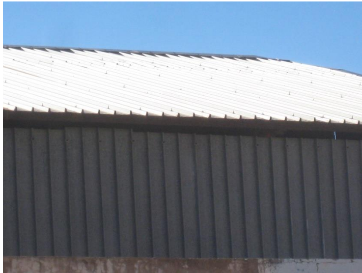
Figure II. 30 : Manque de bardage latéral
