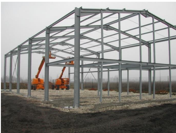
Figure I. 1 : Hall métallique en construction [2].
