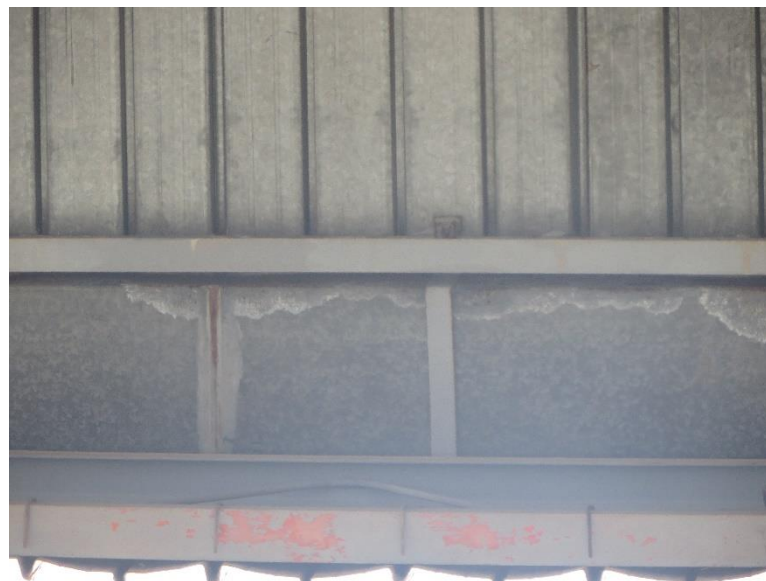
Figure II. 10: Chéneau métallique
