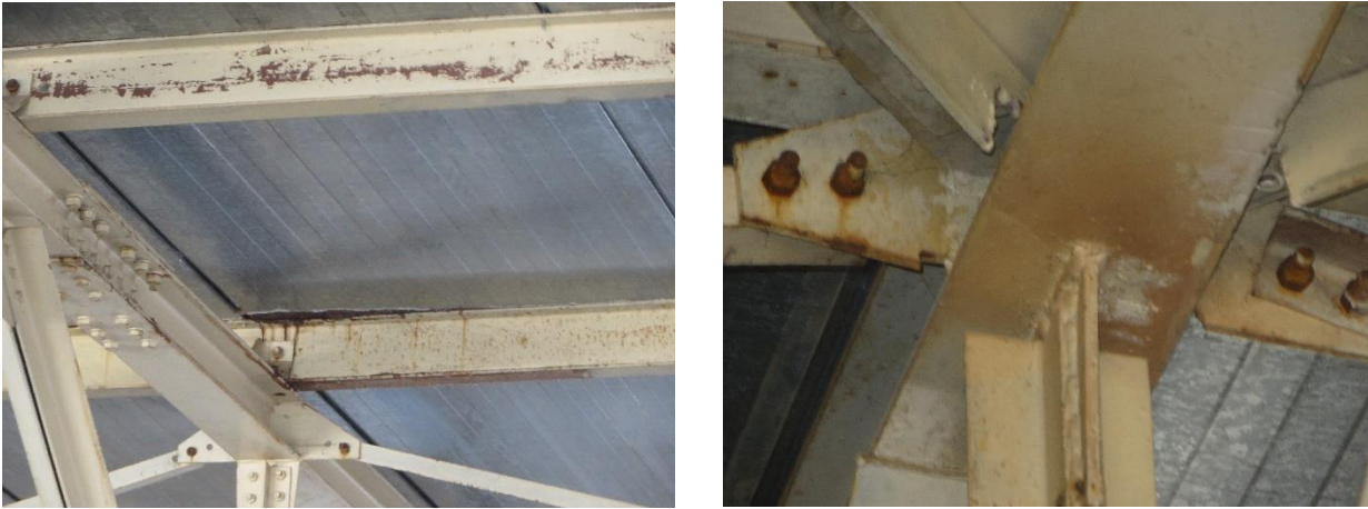
Figure II. 56 : Mauvaise étanchéité de la toiture
