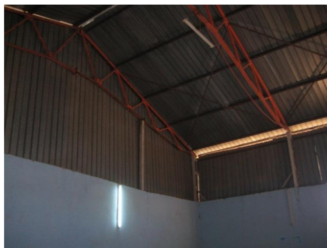
Figure II. 27 : Maque de lisses de bardage.
