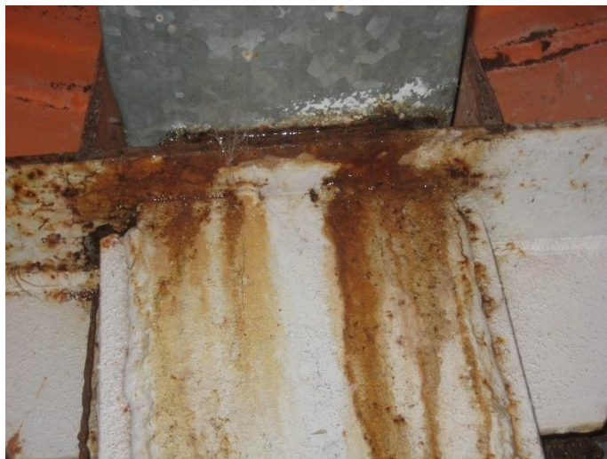
Figure II. 31 : Mauvaise étanchéité du chéneau
