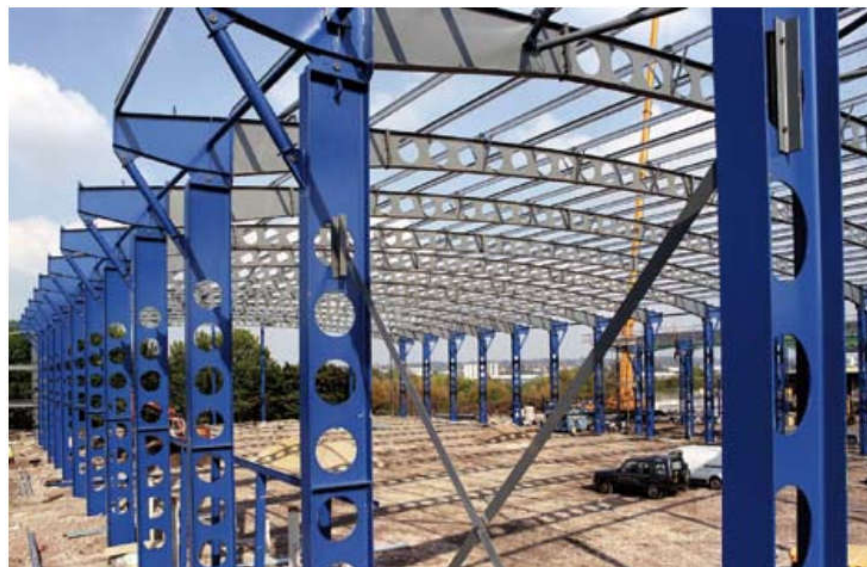
Figure 2.9 Assemblages innovants résistant aux moments dans un bâtiment industriel
