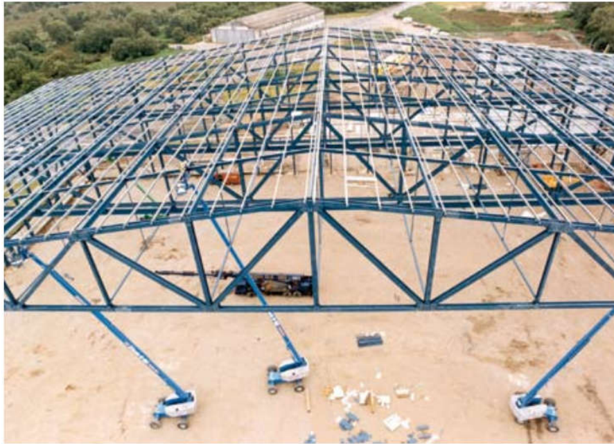
Figure 2.12 Ferme à treillis utilisant des éléments tubulaires
