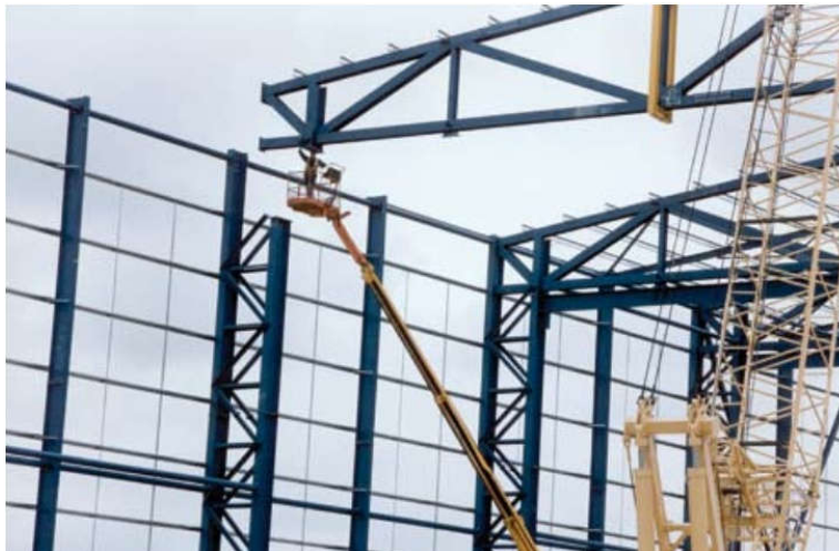
Figure 2.13 Ossature à treillis utilisant des poteaux à treillis
