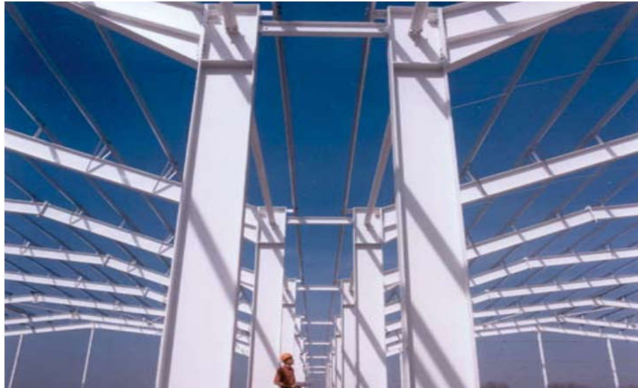
Figure 2.6 Portique à travée unique liaissonné
