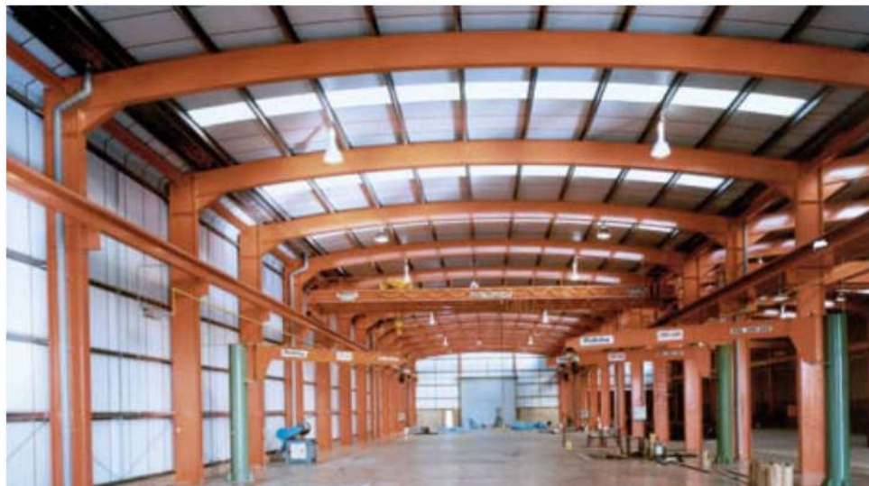
Figure 2.8 Poutres cintrées utilisées dans une structure à portiques
