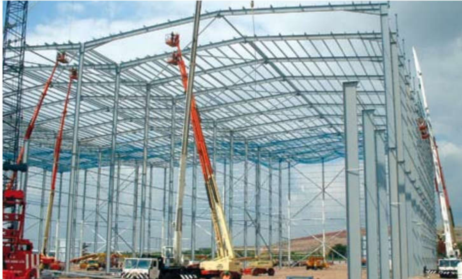
Figure 2.10 Processus d'installation d'un portique modern Barrett Steel Buildings Ltd
