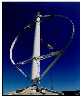
Figure 3 : Eoliennes à axe vertical : rotor de Darrieus (gauche) et rotor de Savonius (droite)
