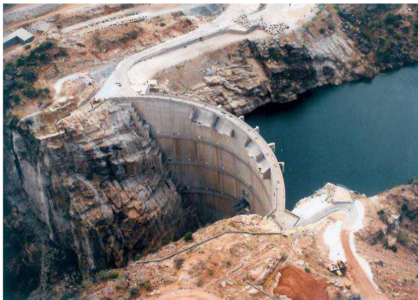
Figure 5.7: Barrage voute de Turkwel au Kenya, hauteur 155 m, longueur en crête 170 m
