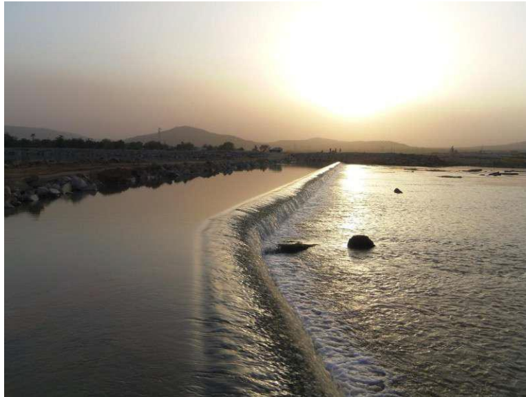
Figure 5.4: Seuil de dérivation de l'aménagement hydro-électrique de Félou sur le fleuve Sénégal au Mali, hauteur 2 m, longueur 900 m
