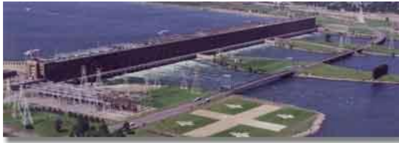
Figure 5.15: Centrale de Beauharnois au Québec : Puissance 1660MW ; hauteur de chute 24m
