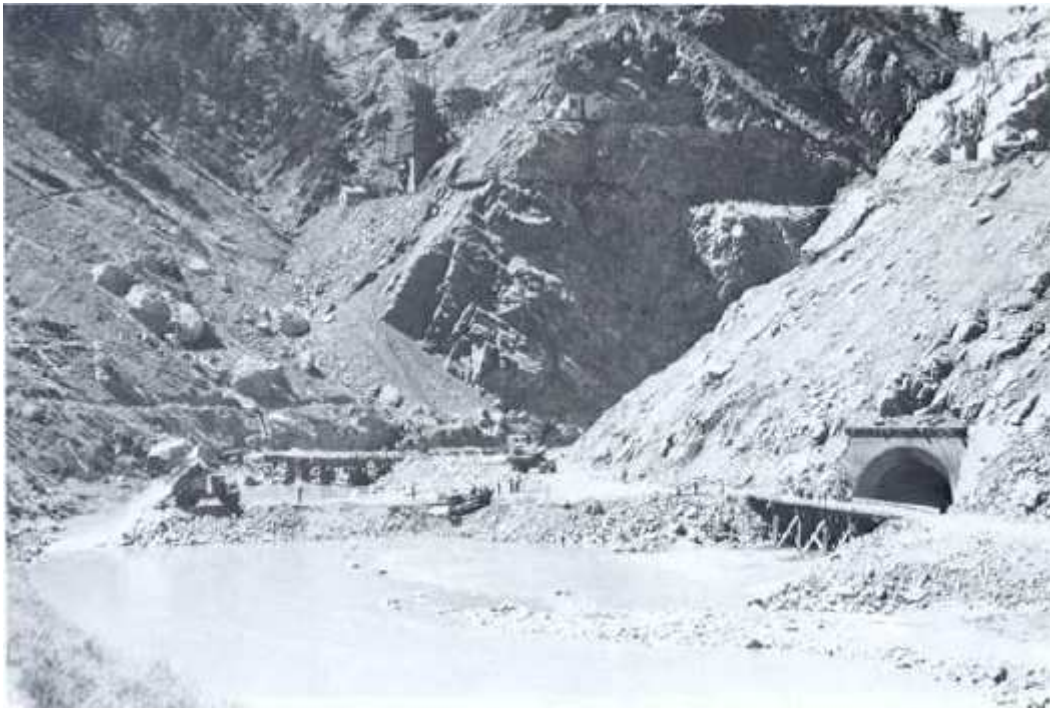
Figure 70: dérivation provisoire avec un tunnel
