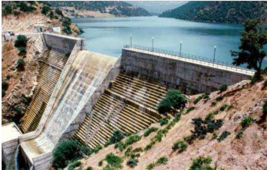
Figure 33: EVC pour un barrage rigide placé en partie centrale (barrage Bab Louta)
