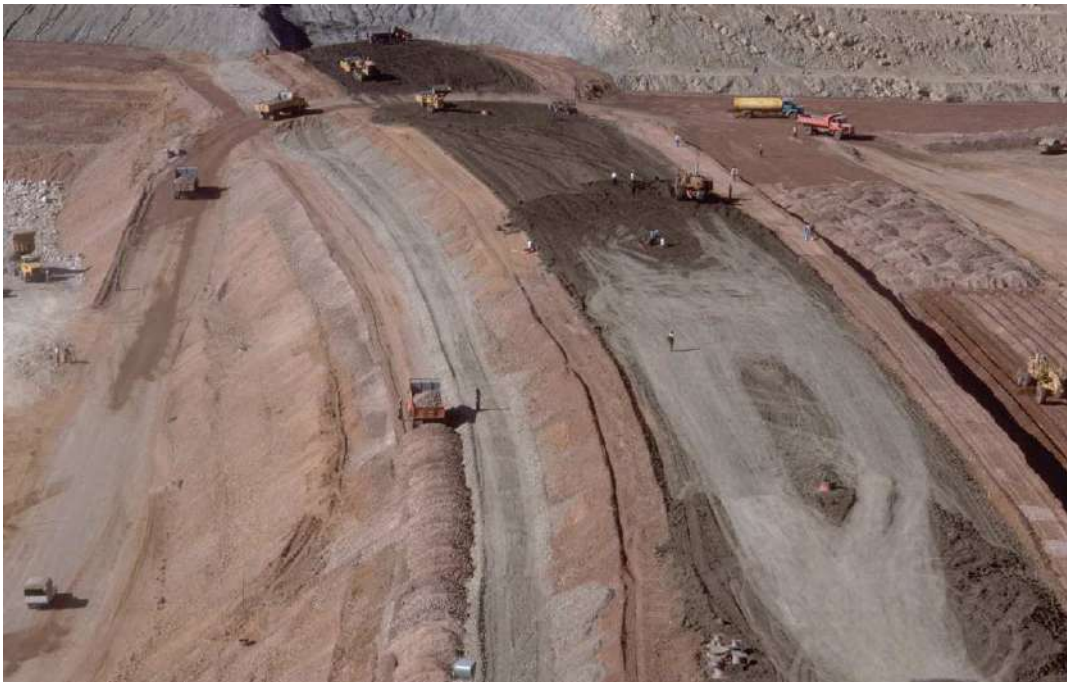
Figure 14: exemple de chantier de barrages à noyau
