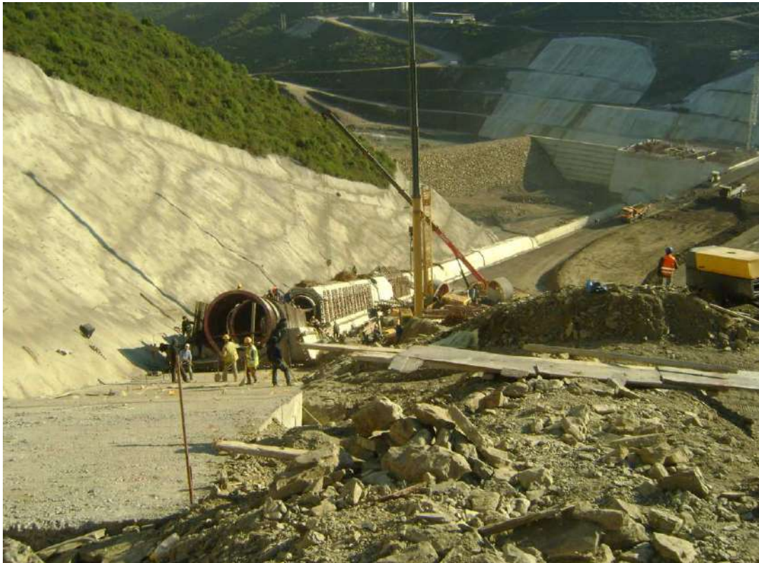
Figure 20: vue de la rive droite de la plinthe du barrage Martil
