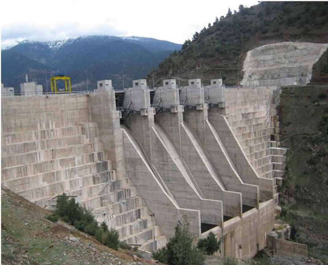
Figure 10 : exemple d'un barrage en BCR (Barrage Yaacoub Al Mansour)
