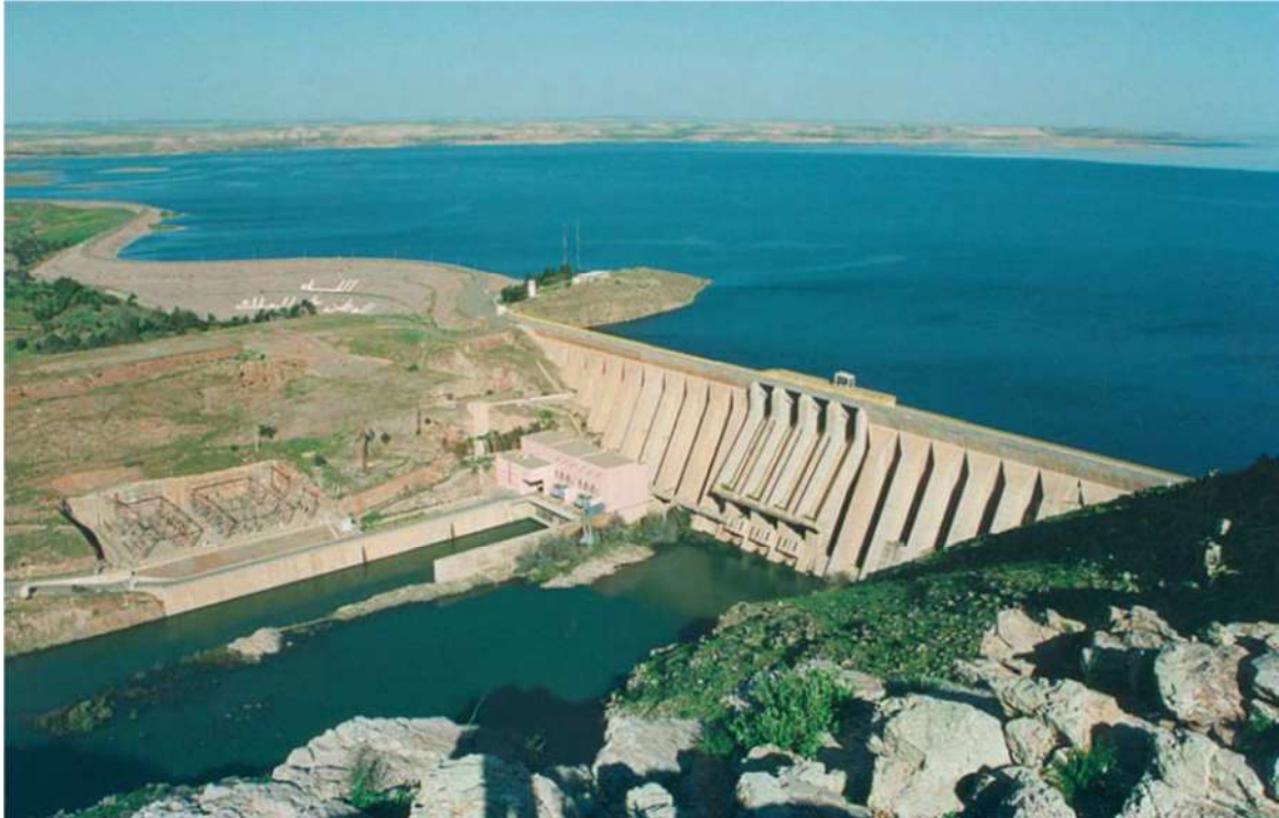
Figure 8: exemple de barrage à contreforts (Al Massira)
