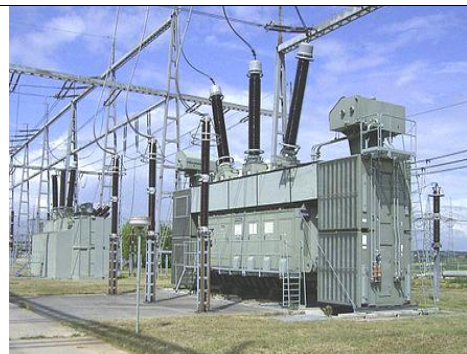
Figure 4 Transformateur de puissance d'un poste électrique HT
