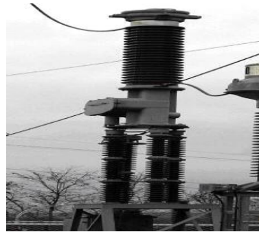
Figure 6 Disjoncteurs à bain d’huile
