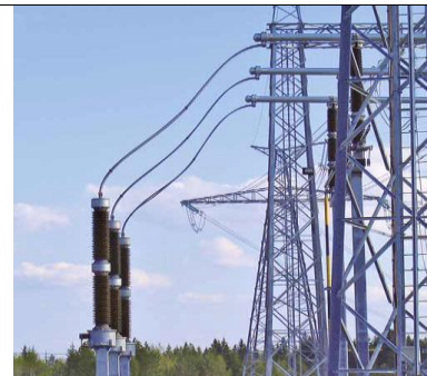
Figure 12 Transformateur de Tension (TT)
