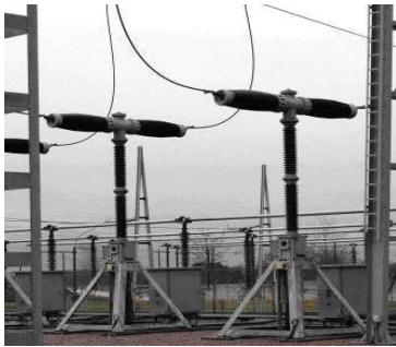
Figure 5 Deux disjoncteurs au SF6
