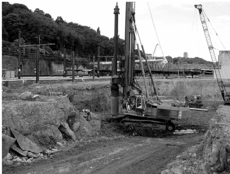
Figure 2. Exemple de mise en place d'un pieu bétonné (photo LCPC).
