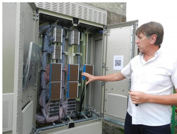
FIGURE 11 – Un sous-répartiteur
