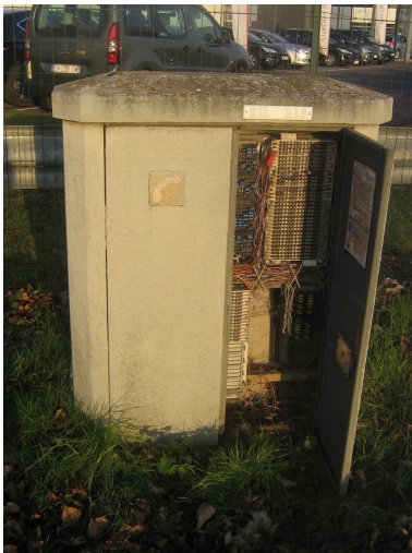
FIGURE 13 – Sous répartiteur
