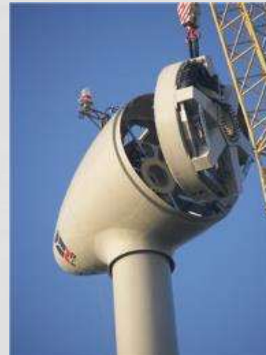
Montage d'un générateur
