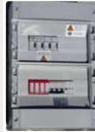
Coffrets de protection DC et AC, compteurs
