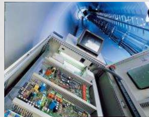
Contrôleur Enercon en pied de mât
