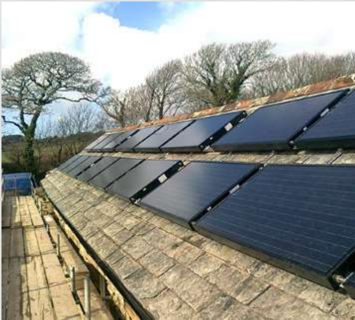
Raccordement de 28 m 2 de panneaux solaires hybrides
