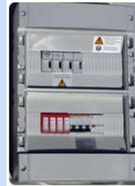
Coffrets de protection DC et AC, compteurs
