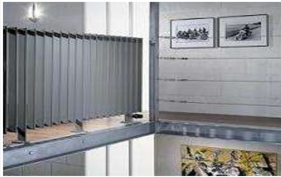
Radiateur basse température
