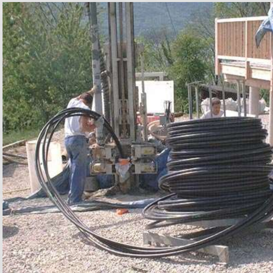
Mise en place des sondes géothermiques
