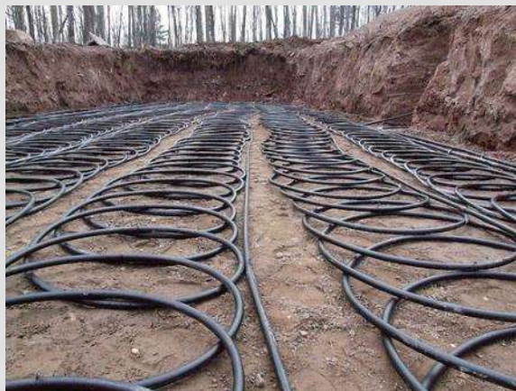
Capteurs en spirale (slinky)
