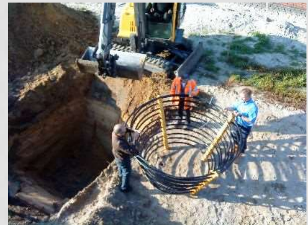
Capteurs verticaux en corbeille
