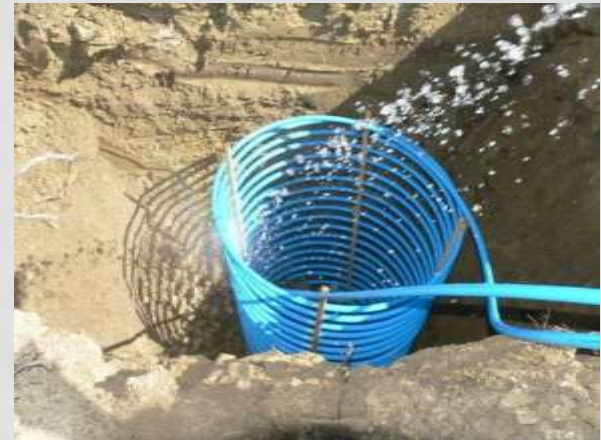
Capteurs verticaux en corbeille
