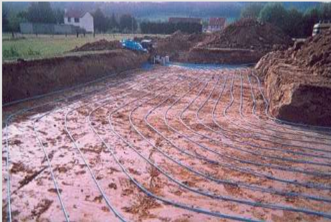
Capteurs horizontaux
