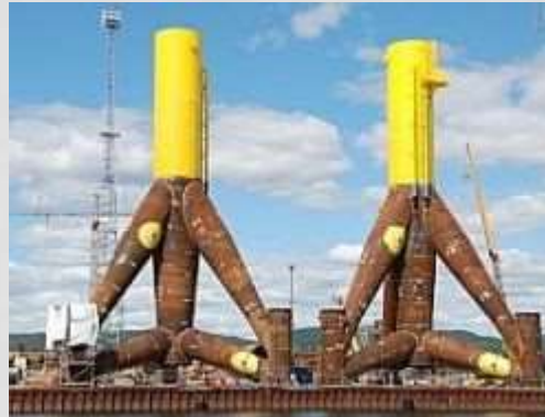
Fondations tripiles (acier : GTS Dunkerque)
