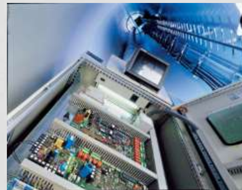
Contrôleur Enercon en pied de mât
