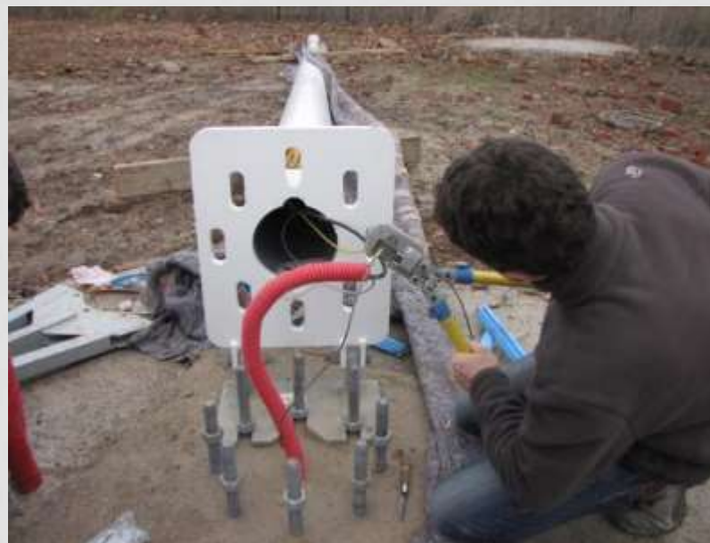
MISE À LA TERRE DE L'ÉOLIENNE
