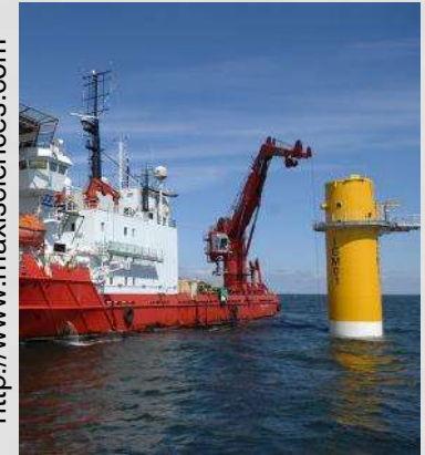
Installation d'une fondation
