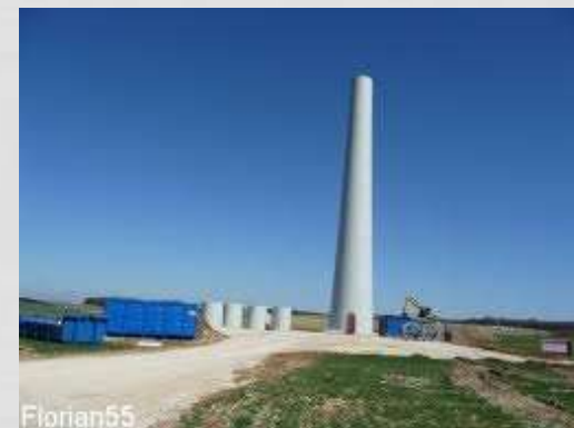
Mât acier : 100 tonnes - Mât béton : 250 tonnes
