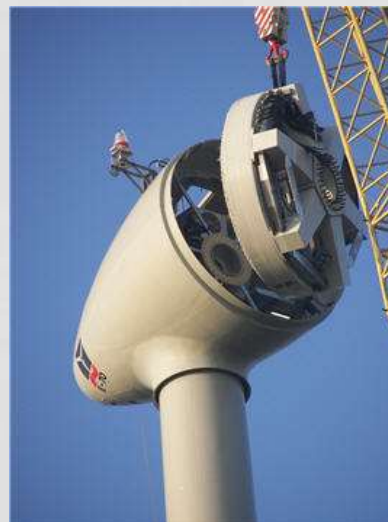
Montage d'un générateur
