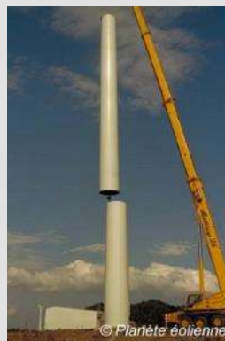
Mât acier : 100 tonnes - Mât béton : 250 tonnes
