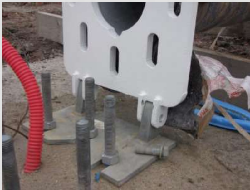
FIXATION DE LA BASE DU MÂT SUR LE SUPPORT
