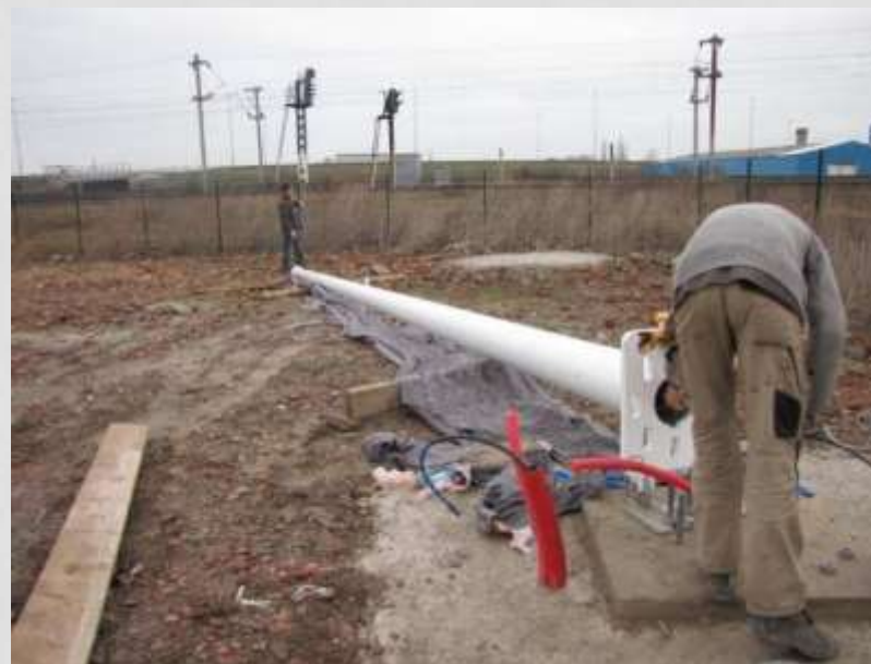
PASSAGE DES CÂBLES DANS LE MÂT
