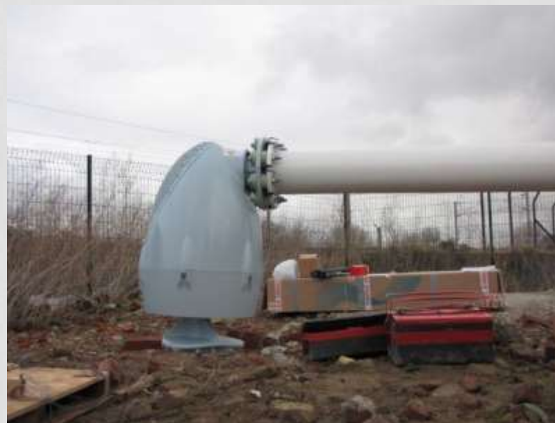
LA GÉNÉRATRICE EST FIXÉE AU MÂT
