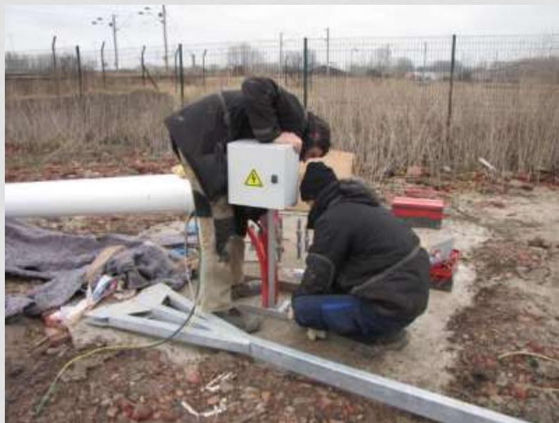
MISE EN PLACE DU BOITIER ÉLECTRIQUE
