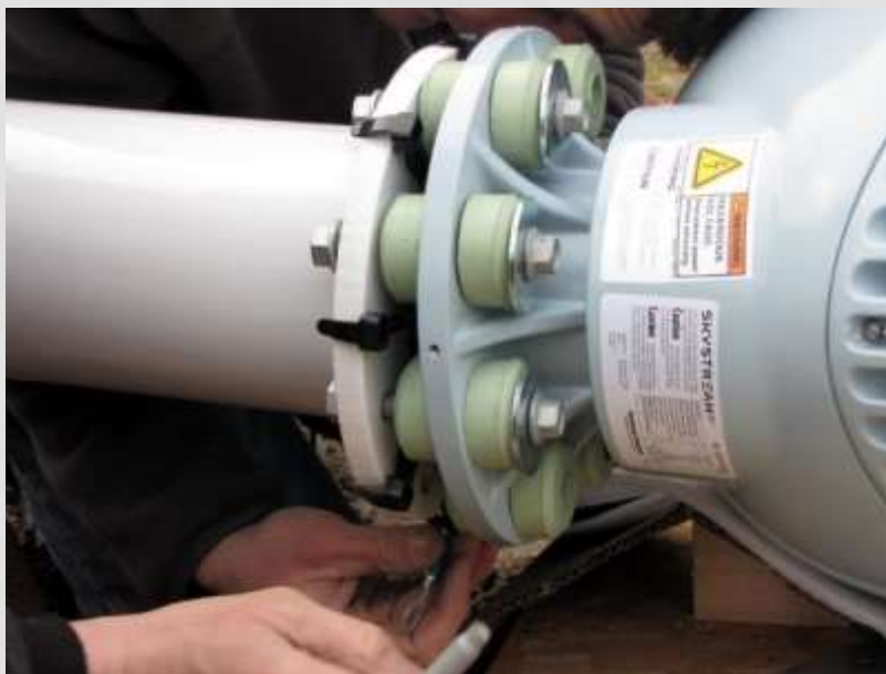
FIXATION DE LA GÉNÉRATRICE AU MÂT
