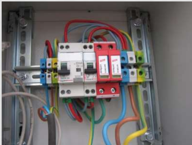
CÂBLAGE DU COFFRET ÉLECTRIQUE TERMINÉ (3X16 MM 2 )
