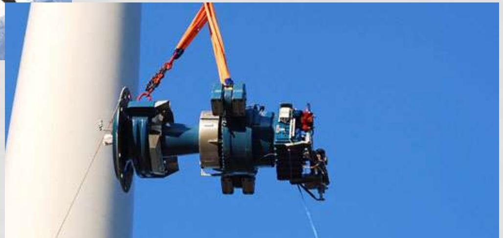
Remplacement de la boîte de vitesse
