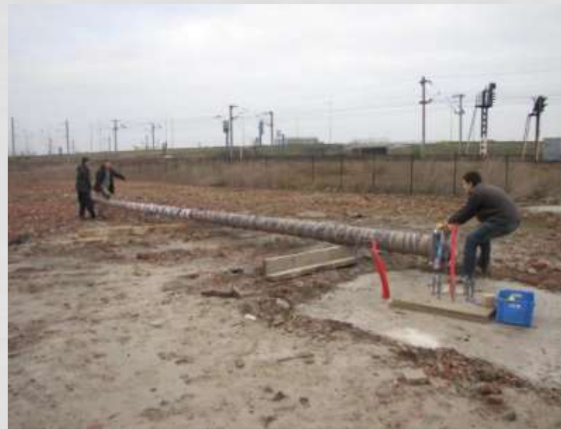
LE MÂT DE 300 KG EST PIVOTÉ AFIN DE LE METTRE DANS L'ALIGNEMENT DU SOCLE
